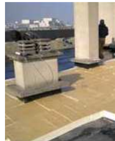
Isolation de la toiture terrasse © M.Andrieux
