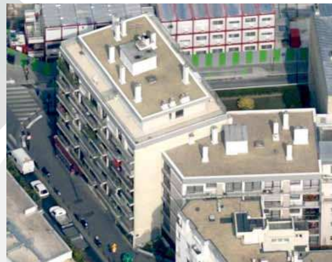
Vue aérienne du 59-61 rue Picpus / 1 rue Dagorno 75012 PARIS © Paziaud
